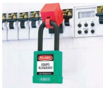
BLOQUEO DIELECTRICO DE INTERRUPTORES
